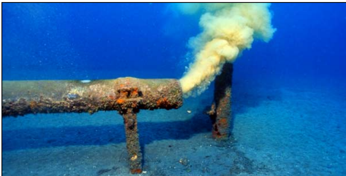
Foto 16. Vertido de aguas residuales urbanas a través de un emisario submarino.
