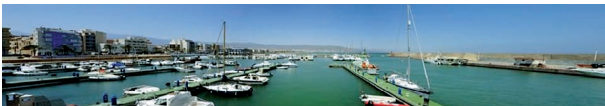
^ imagen 4.3. Puerto de Roquetas de mar (fotografía Agencia de Puertos de Andalucía).
