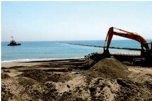
^ imagen 4.11. Actuación de regeneración de una playa mediante aporte de áridos.
